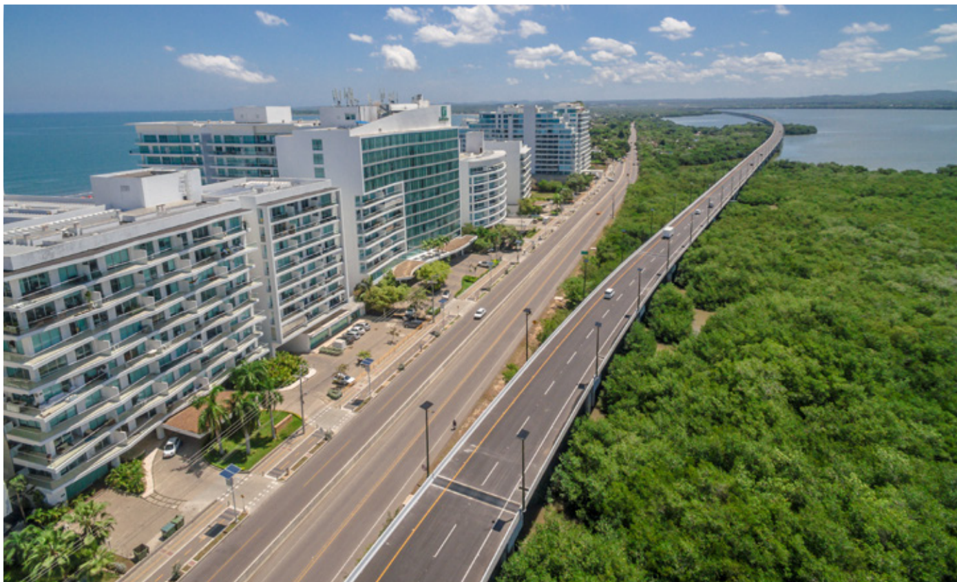
Foto: Viaducto el Gran Manglar, sobre la Ciénaga de la Virgen - Cartagena, Colombia
