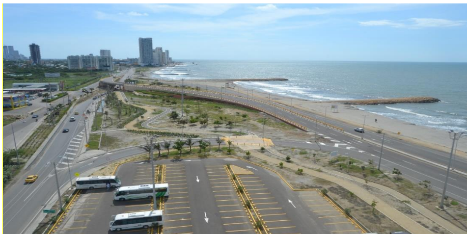
Figura 3. Puente Vehicular Avenida Santander
