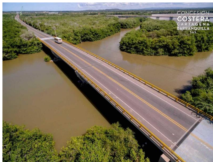
Figura 6. Vista general puesto la Boquilla
