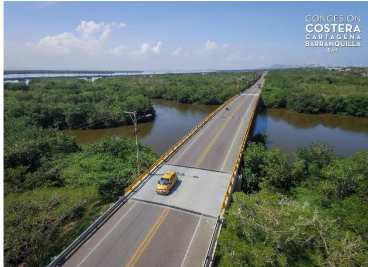
Figura 7. Vista general puente El Cañón
