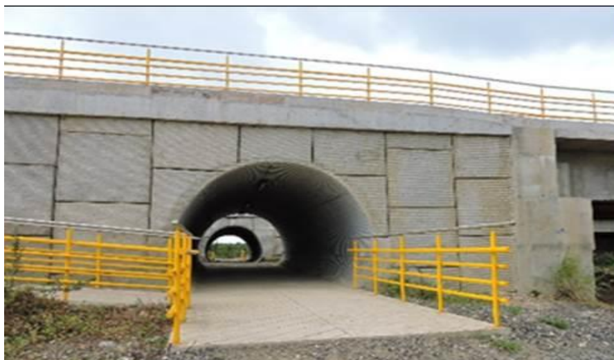
Figura 14 Paso Peatonal Sector Tierra Baja
