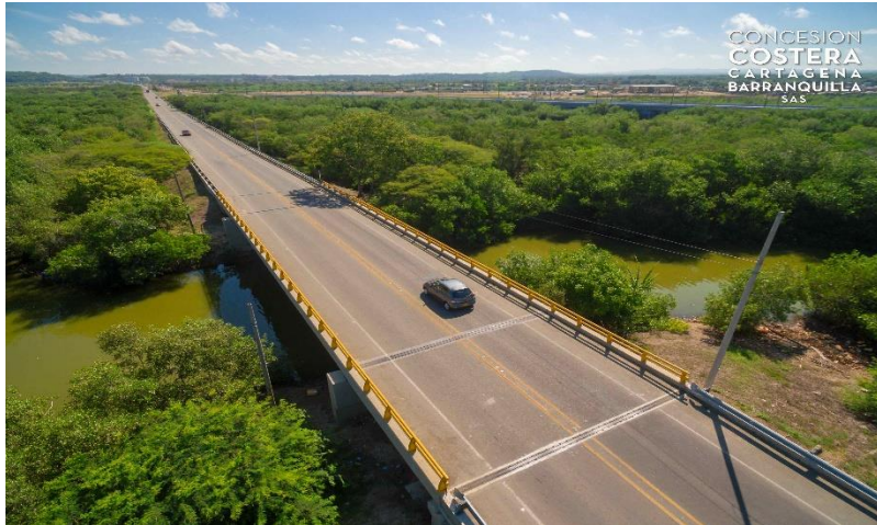
Figura 9. Vista general puente Juan Polo
