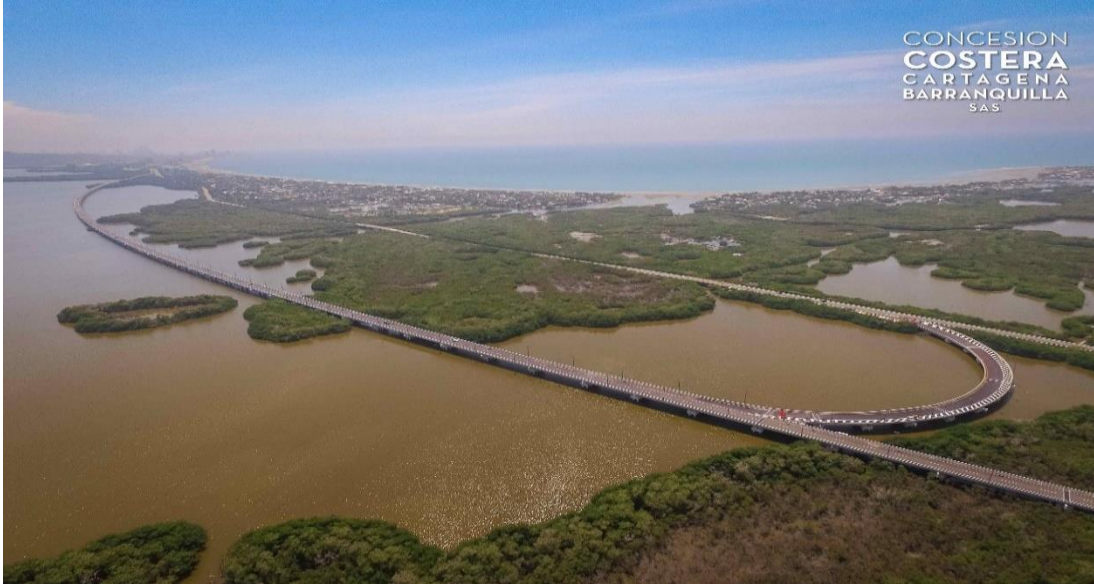
Figura 11. Retorno Gran Viaducto Sector 1 UF2
