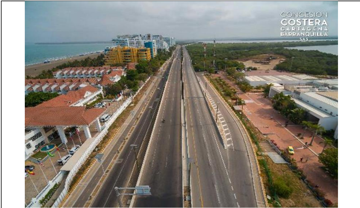
Figura 13. Intersección elevada Cielo Mar
