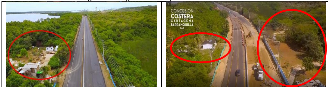
Registro Fotográfico 4. Tejido urbano discontinuo
