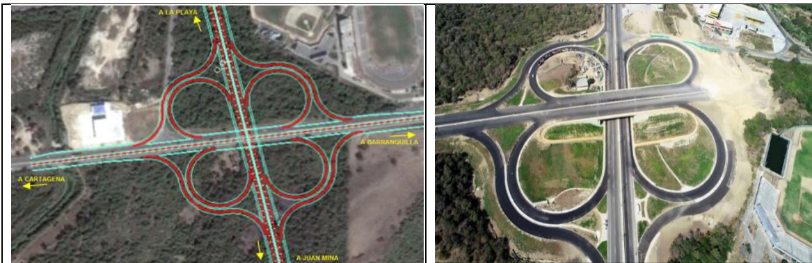
Figura 9. Intersección Vía al Mar – UF6
