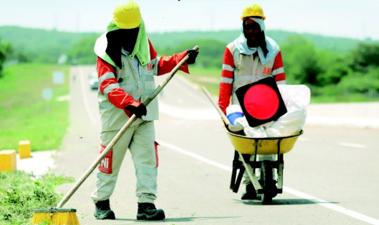
Foto: Actividades de mantenimiento del corredor vial UF8 (Galapa - Vía al Mar - Las Flores)
